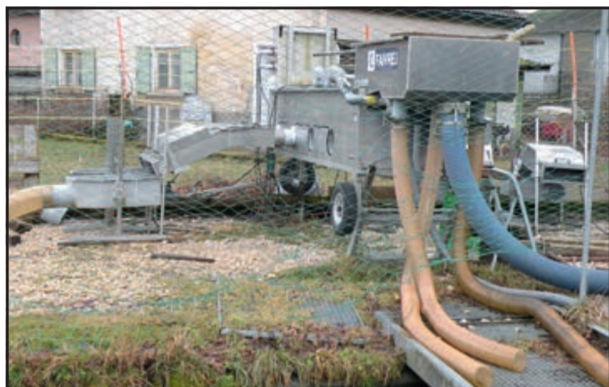
Sur cette photo, on remarque les filets de protection contre les oiseaux et le « trieur-compteur » permettant de sortir les truites de l'eau avant leur envoi en zone de stabulation.
